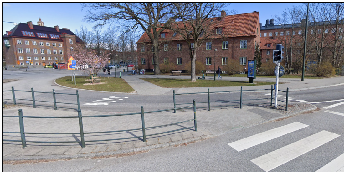
Bild 4. Passagen över den fria högersvängen för buss. Räcke gör att trafikljusets övergångsställe och passagen ligger förskjutna i förhållande till varandra.
